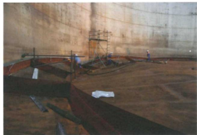
写真10-5-1 浮き蓋の破損状況
