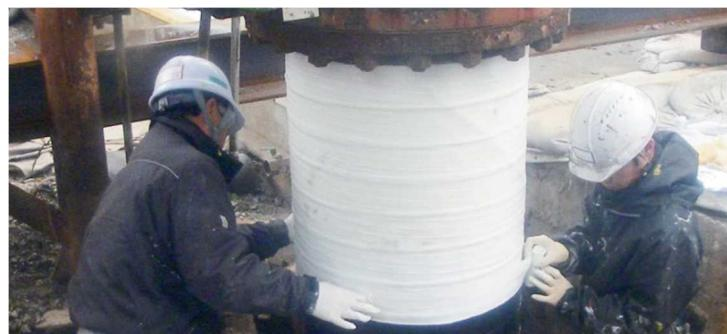
写真 8-3-9 応急用固定バンドの例 (マホータイの施工)
