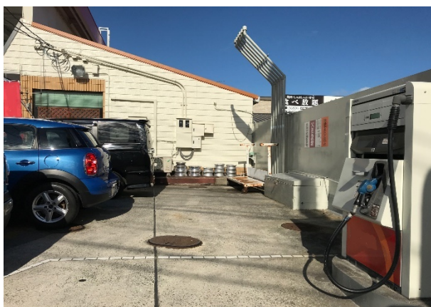
図14 遠方注油口付近の様子
