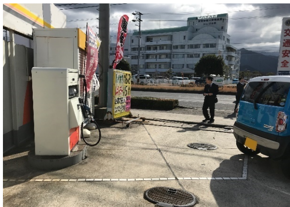
図12 固定注油設備前の作業スペース
