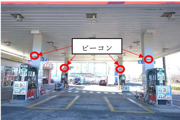
図10 ビーコン設置位置 (大規模施設)
