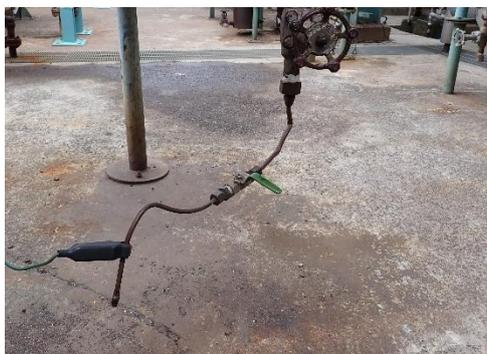
写真1 可燃性蒸気が周期的に又は一時的に発生すると考えられる箇所の例（サンプル口）
