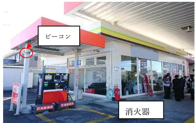
図11 ビーコン設置位置 (固定注油設備)
