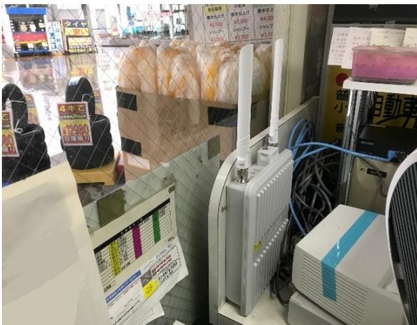
図 14 Wi-Fi 機器（給油停止及び一斉停止）
