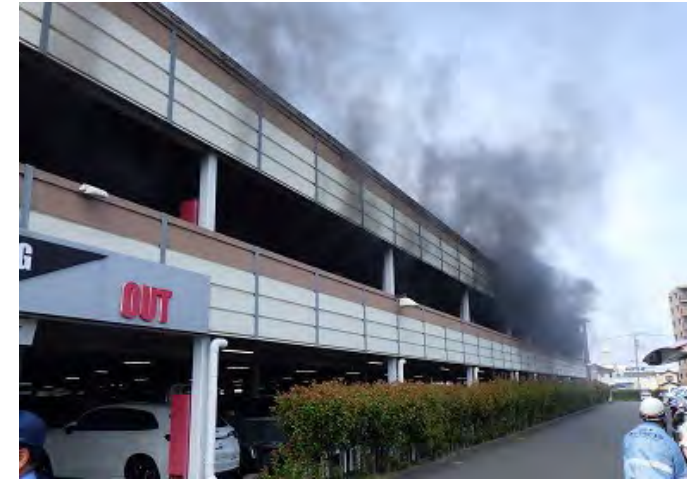
<建物外観（火災時）>
