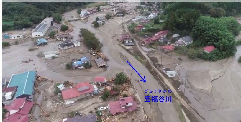
令和元年台風19号 土砂・洪水氾濫による被害状況 (宮城県丸森町)
