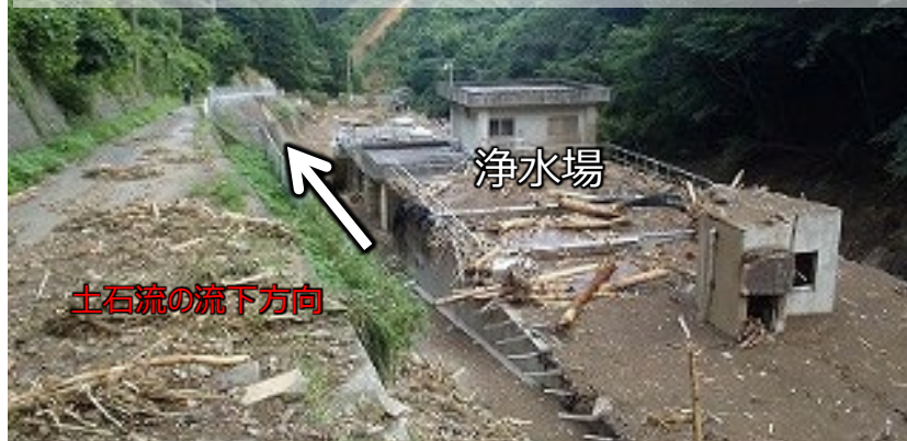
平成30年7月豪雨 浄水場の被災状況 (愛媛県宇和島市吉田町、影響約6,500戸(約15,000人))
