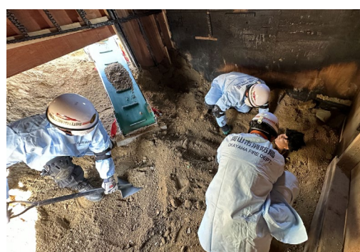
【ベルトコンベアによる排土】
