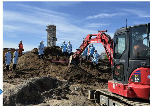
【重機による排土】
