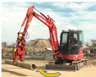
【電柱持ち上げ旋回例】
