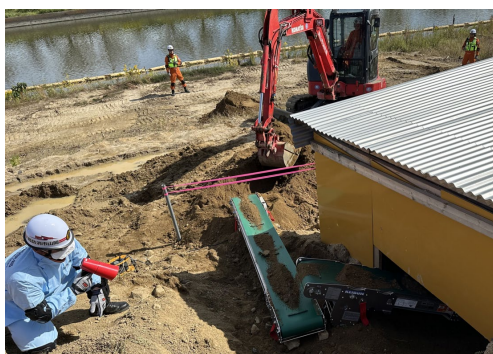
【重機による排土】
