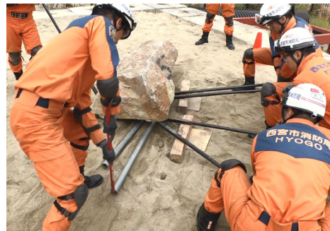
【単管パイプの挿入】
