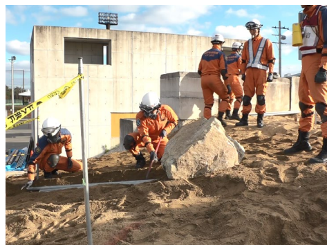
【単管レール敷設】
