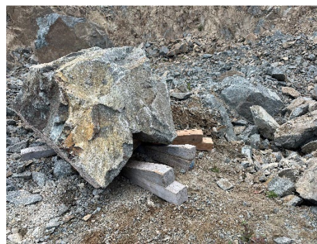
【岩石の安定化例】
