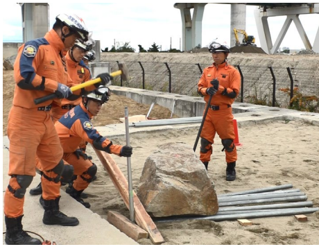
【杭の打ち込み】
