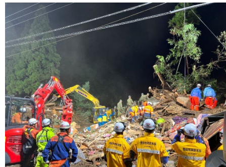
【重機との連携状況】
