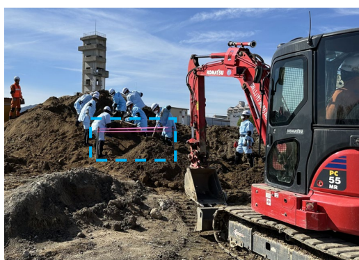
【人による掘削（一方掘り）】
