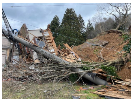
【建物 C 倒壊状況】
