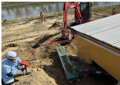
【重機による排土】
