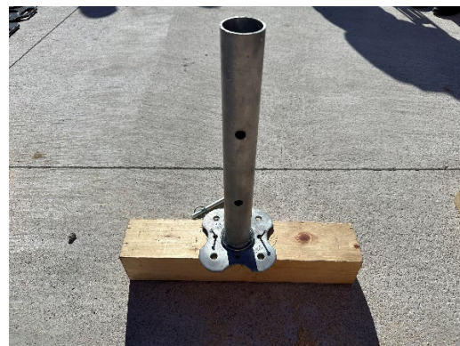
【パイプサポート下部：分解時】
