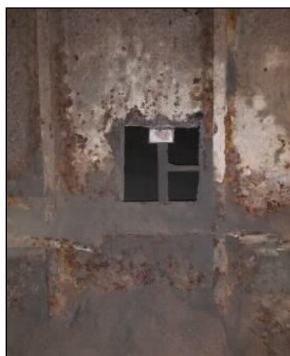
【作成開口部(ガス溶断)】
