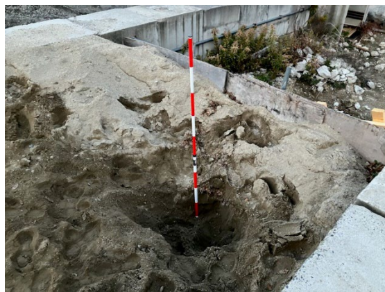
掘削箇所をポールで計測
