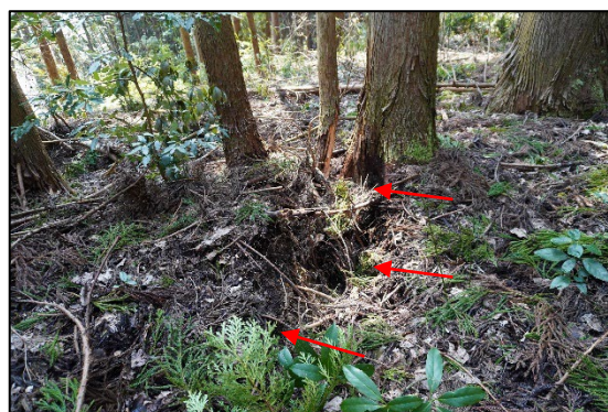
(地すべり隣接斜面の亀裂)
