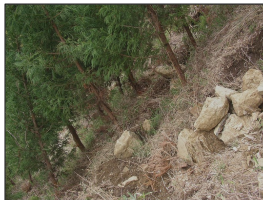
(地すべりで谷側へ傾いた樹木)
