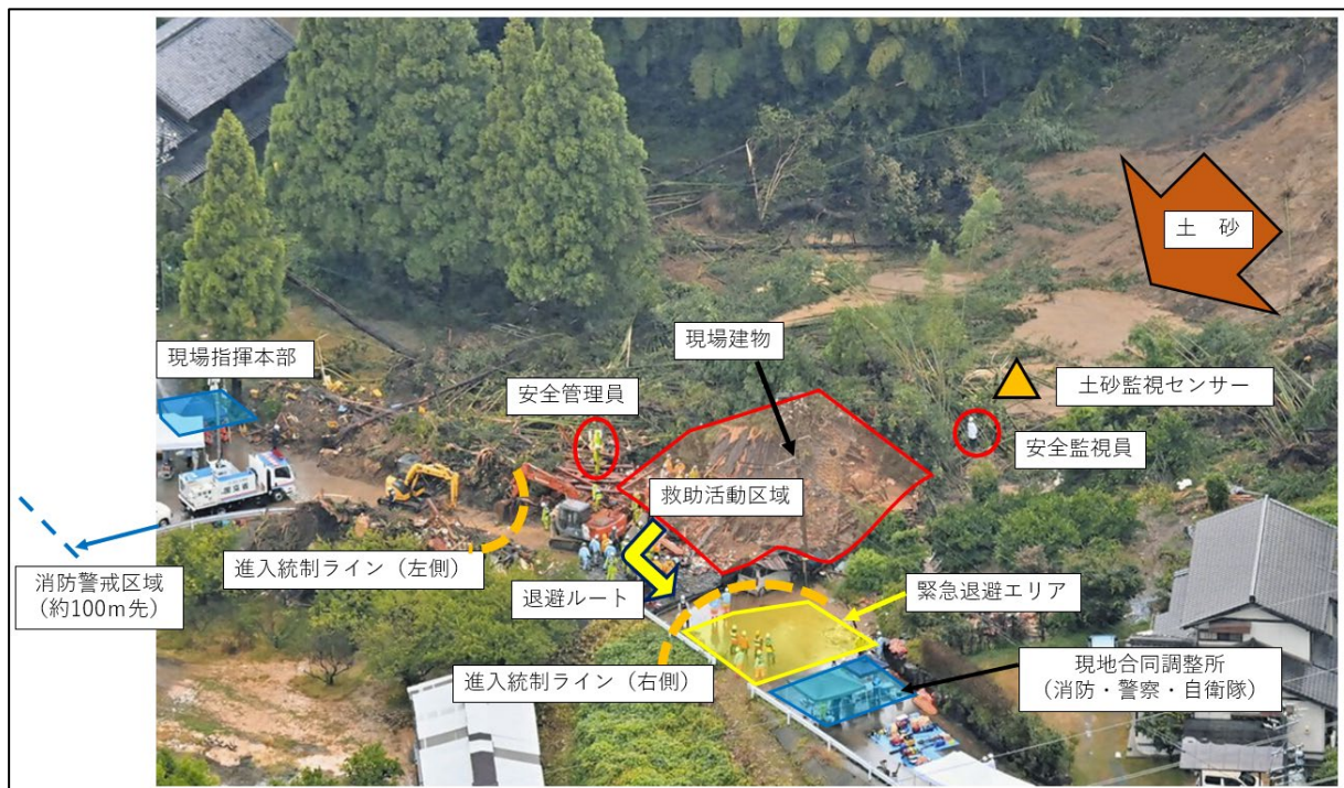
(蒲郡市での土砂災害対応：名古屋市消防局)
