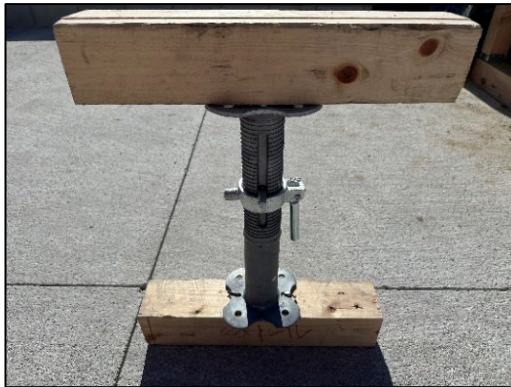
【パイプサポートと木材の設定】
