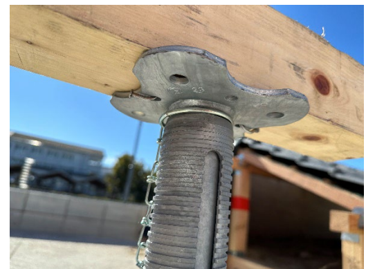
【パイプサポート上部：分解時】
