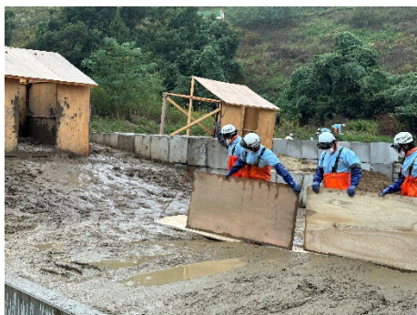
【⑥進入の状況】
