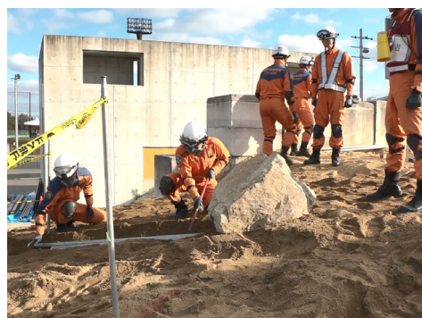
【単管レール敷設】
