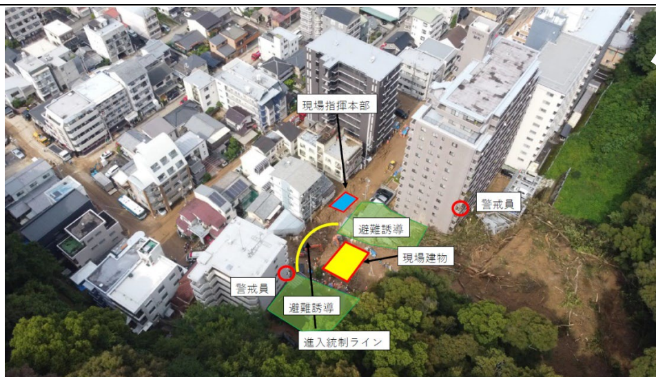
【災害現場周辺の全景】
