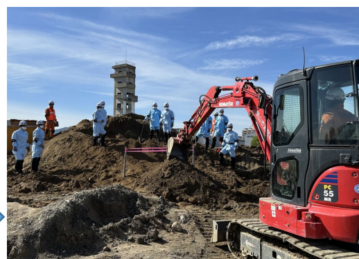
【重機による排土】
