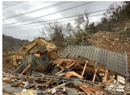
【重機による屋根等の排除】 (国土交通省 HP より)
