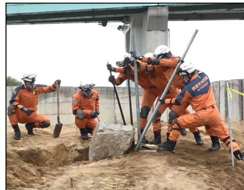
【ボールでの落とし込み】
