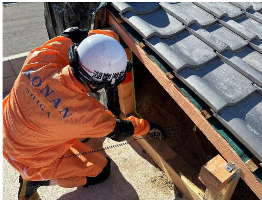
【設定位置の計測：サイジング】
