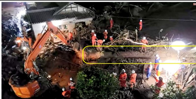
【活動障害となっている直径約 1.5m、長さ約 15mの倒木除去の状況】
