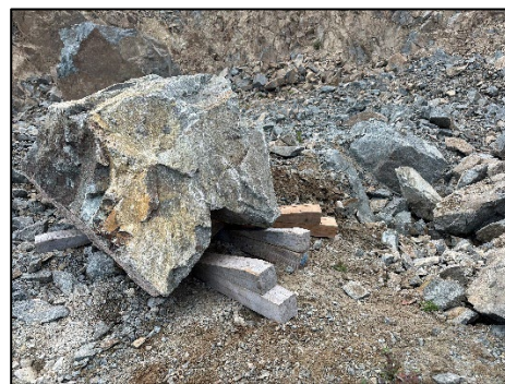
【岩石の安定化例】
