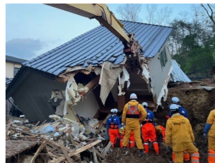
【建物 A 重機連携状況】
