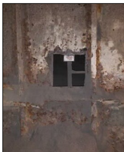
【作成開口部(ガス溶断)】
