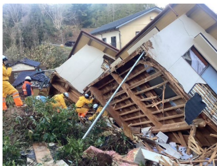
【建物 A 安定化状況】
