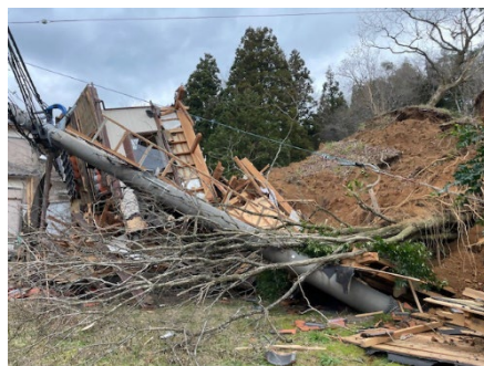
【建物 C 倒壊状況】
