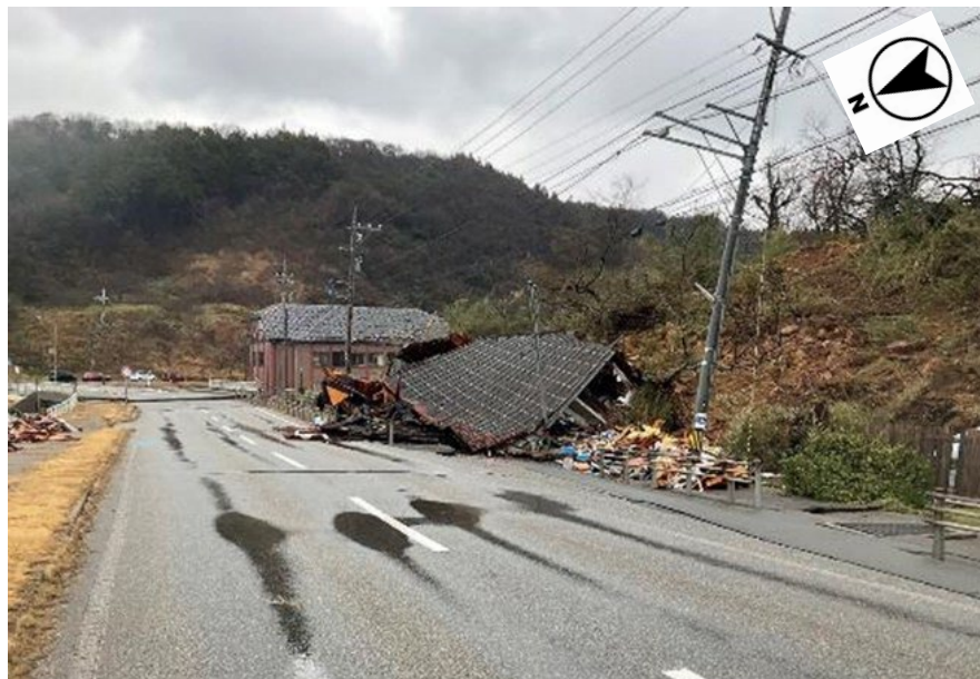
【災害現場周辺の全景】
