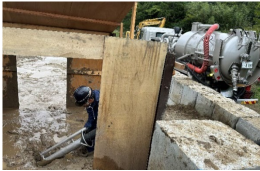
【吸引車による土砂吸引】
