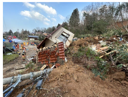
【建物 B 倒壊状況】
