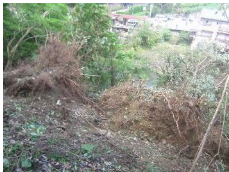
提供：京都市消防局 【土砂崩落の状況】
