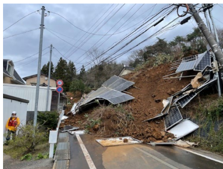
【土砂流出状況】
