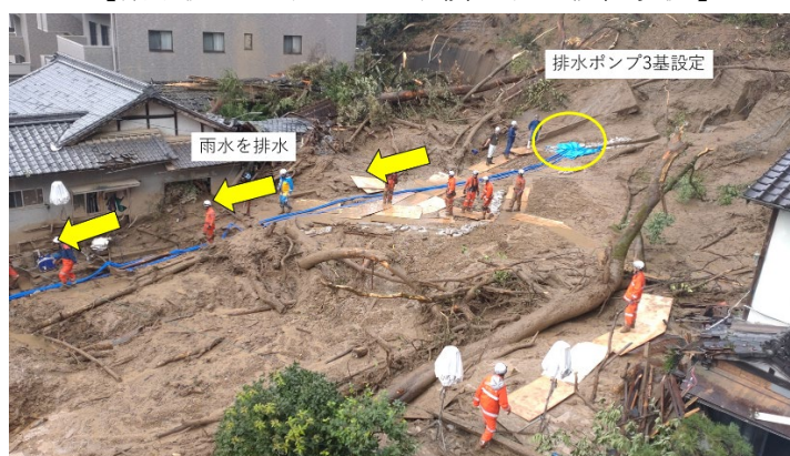
【排水ポンプ活用による応急措置状況】
