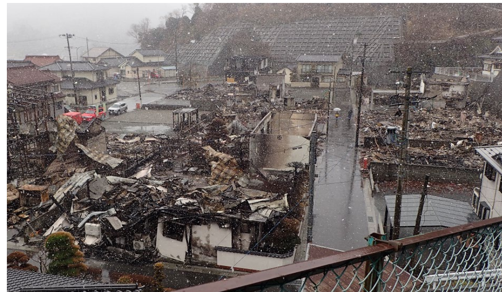
消研・予防課・大船渡消防本部による建物火災の調査
