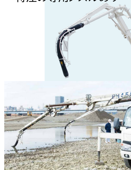
コンクリートポンプ車による 自然水利からの吸水
