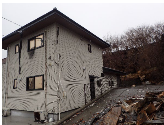
図 4-32 建物 a の外観
