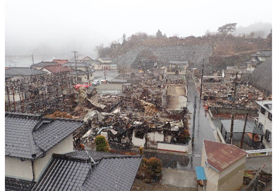
図4-22 綾里港地区の被害状況
