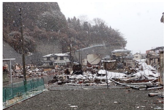
図4-24 (A) 区画の状況
