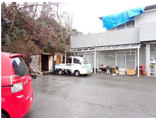
図4-35 建物dの外観
