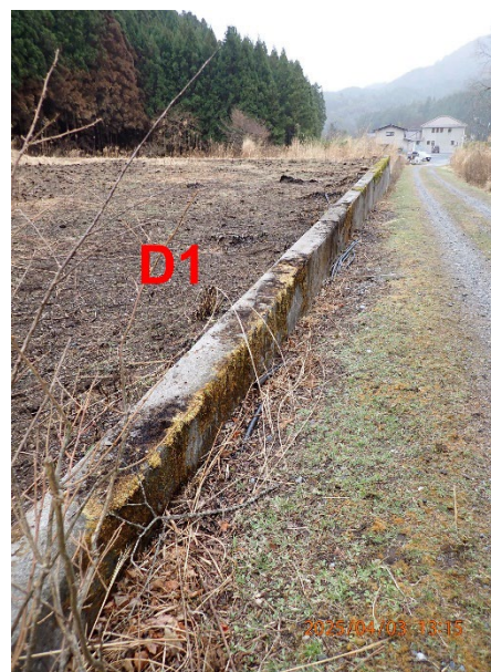
図4 D1 とその西側の道路を北から撮影。コンクリート壁に付いた苔が焼けており、その下には焼けたススキが散らばっている。
