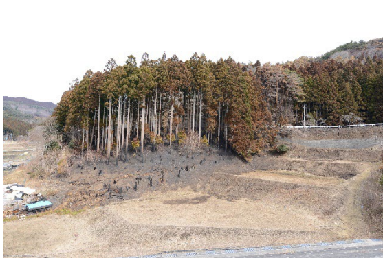
図 3-1 敷地及び山林の焼損状況
