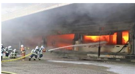
R3大阪府大阪市倉庫火災 (鎮火5日間)
