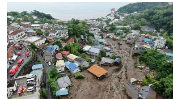
令和3年熱海市土石流災害
