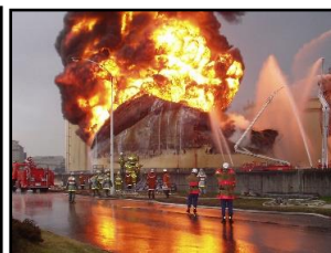
タンク全面火災
