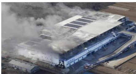
H29埼玉県三芳町倉庫火災 (鎮火12日間)
