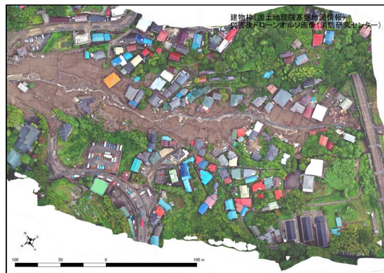
ドローン撮影により作成した土石流発生現場のオルソ画像
