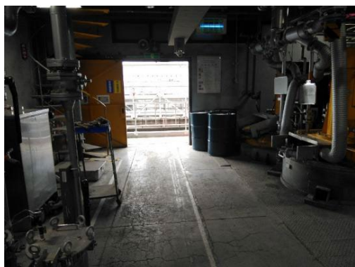
出入口①の開放状況
