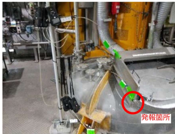
【図 7 窒素パーージ開始時の発報箇所】
