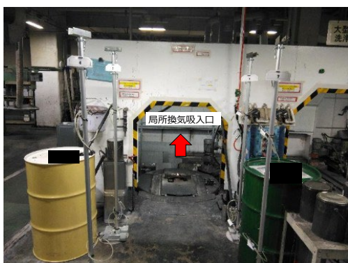
釜洗い場 換気状況
