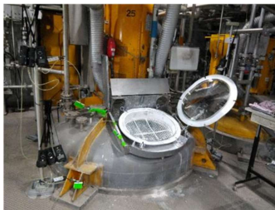
【図 8 原料投入口の開放状況】
