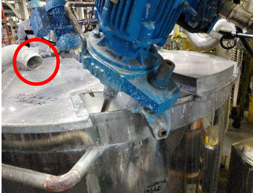
局所換気用ダクトによる換気状況
