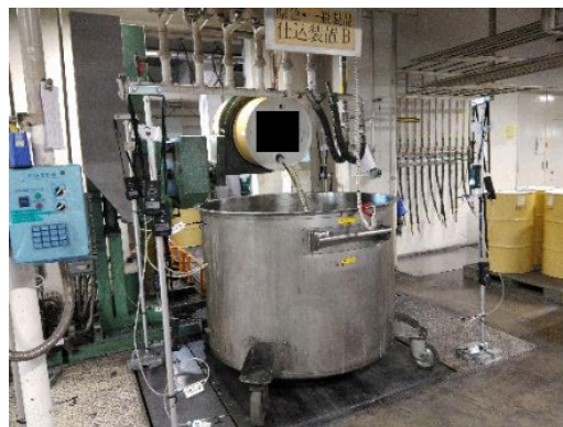
ドラムからの原料危険物の投入状況
