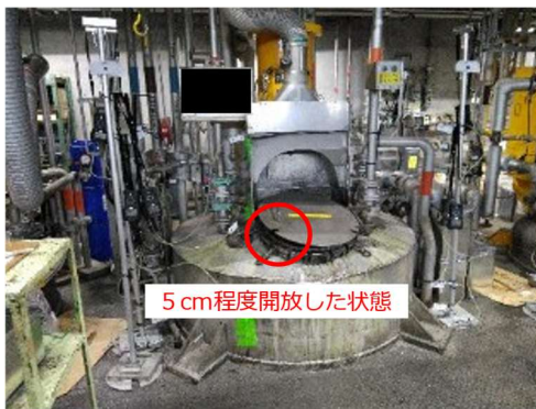
【図 20 蓋の開放状況】
