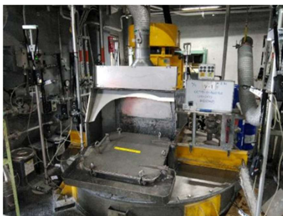
【図 16 原料投入口の閉鎖状況】
