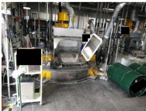
【図14 原料投入口の開放状況】
