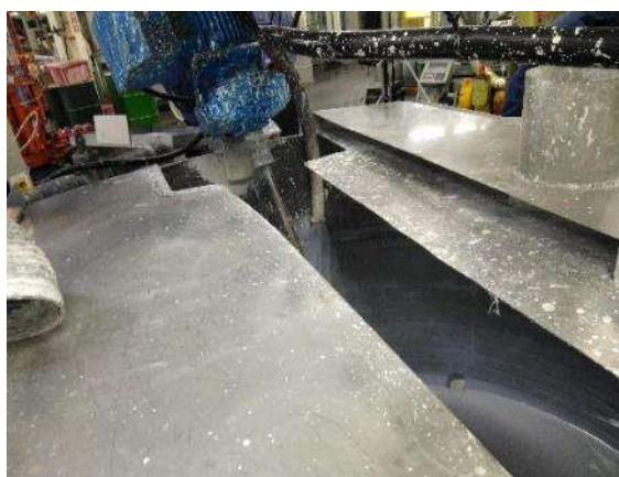
【図40 蓋の開口状況】
