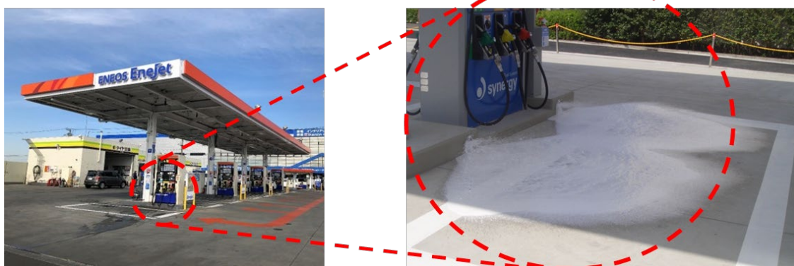
セルフスタンドにおけるパッケージ型泡消火設備のイメージ
