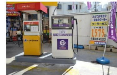
図 2-40 設置された E10 給油用仮設簡易タンク
