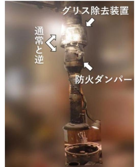
※ 火気設備についてはあまり見られないが、火気器具に付随する上引き排気ダクトは、グリス除去装置、火炎伝送防止装置の設置位置が適切でないケースが見られる。これは、居抜き物件の改修などで、既存のダクトを活かしつつ簡易な延長や接続工事を知識や経験が少ない業者などが施工することも一因となっている可能性がある。
