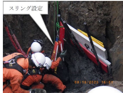
【サーバイバスリングによる確保】
