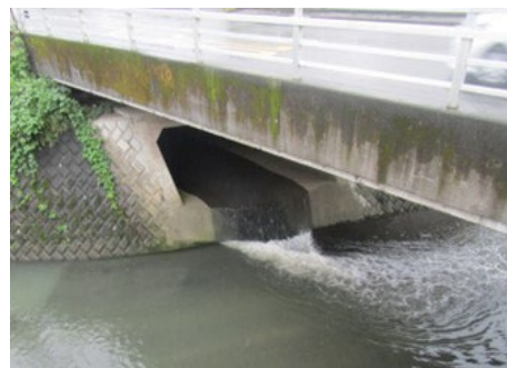
【雨水吐出口の状況】
