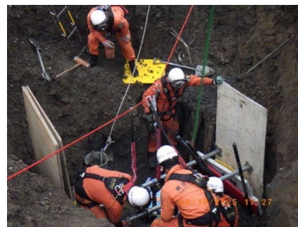
【コンパネを活用した土止め設定】
