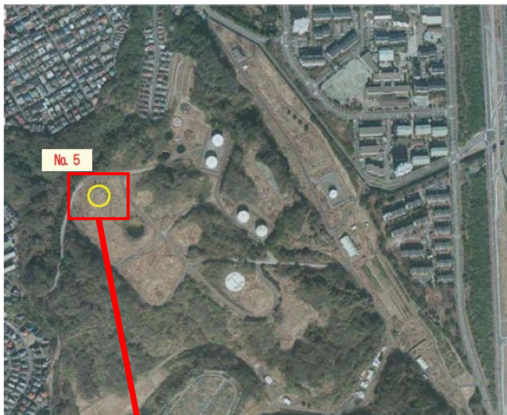
【災害現場の全景】
