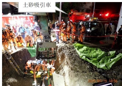
【土砂吸引車による活動状況】
