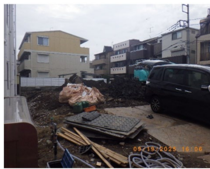
【現場北側からの状況】
