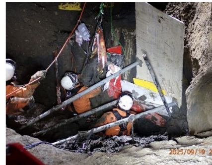
【一箇所吊り救出の状況】
