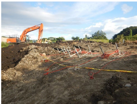
【アンカー設定状況】
