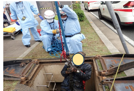
【機材搬入孔からの救出状況】
