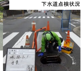
下水道点検状況
