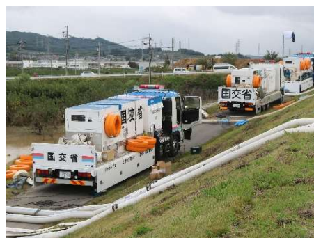
排水ポンプ車による 緊急排水作業
