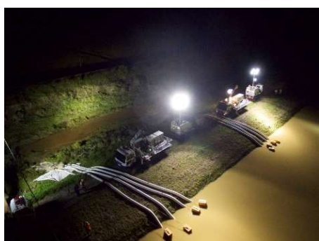
排水ポンプ車による 緊急排水
