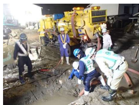
側溝清掃車による 堆積土砂の撤去
