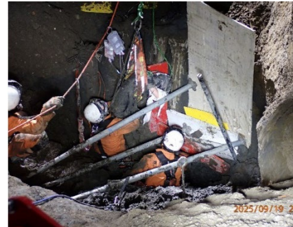
【一箇所吊り救出の状況】
