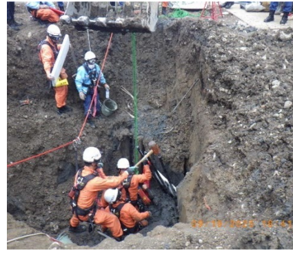
【土留め設定状況】
