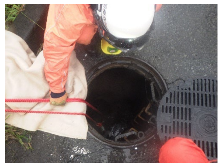
【雨水管内の搜索状況】
