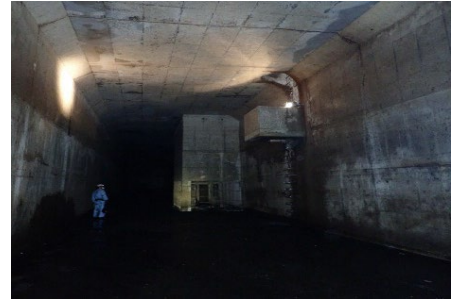
【雨水調整池内部】
