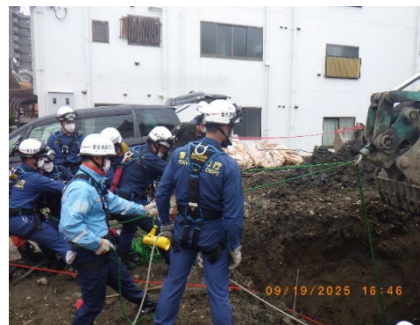
【地上での進入隊員確保状況】
