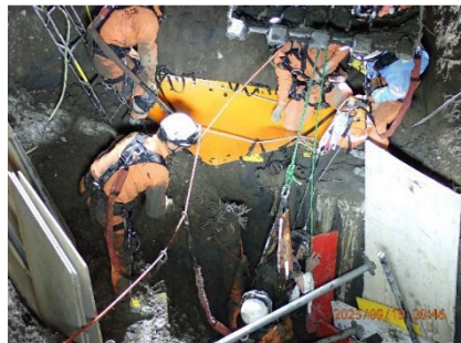
【掘削穴の中断までの救出状況】
