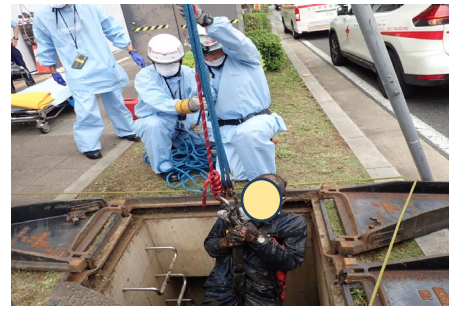
【機材搬入孔からの救出状況】
