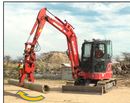
【電柱持ち上げ旋回例】
