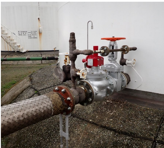
図 5-13 260kL ガソリントankの 150A 浸感弁
