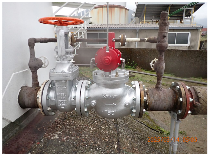
図 5-13 260kL ガソリントankの 150A 浸感弁
