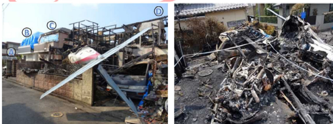
図 8.14. 出火現場の様子
