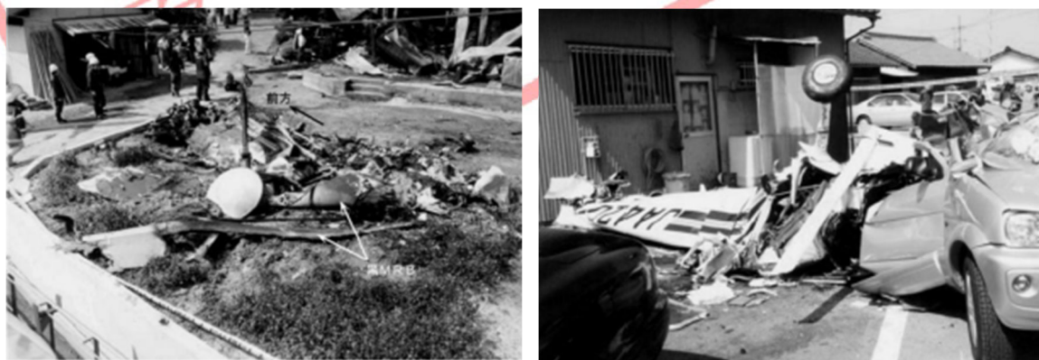
図 8.15. 事故現場の様子
