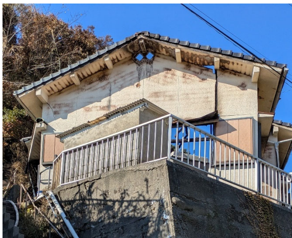
写真 6.23 焼失区域から離れた位置で焼損した建物（地点①）
