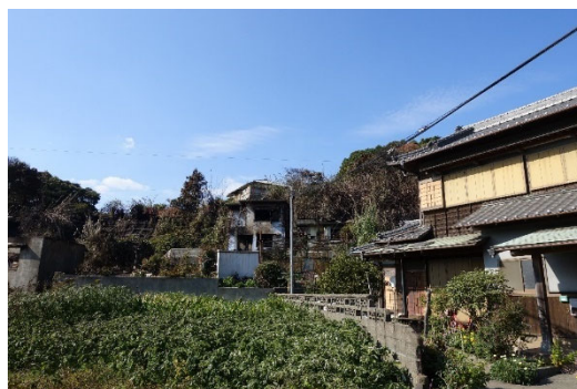
写真 6.11 火災後の現地の様子（地点②）
