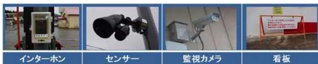
図2機器の設置状況
