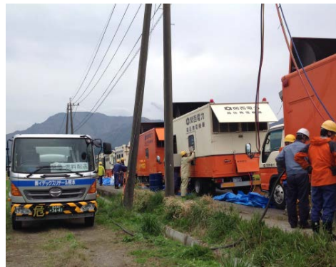
停電地域において「移動電源車」に タンクローリーから軽油を供給 (熊本県阿蘇市／2016年4月18日)
