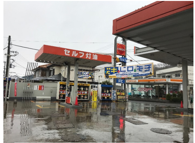
固定注油設備 5・6レーン（横）
