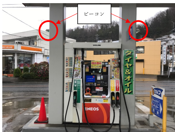
図6 ビーコン設置位置（小規模施設）
