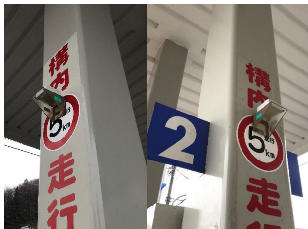
図7 ビーコン拡大図（小規模施設）
