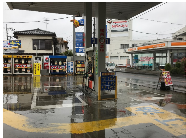
固定給油設備 1・2 レーン（横）
