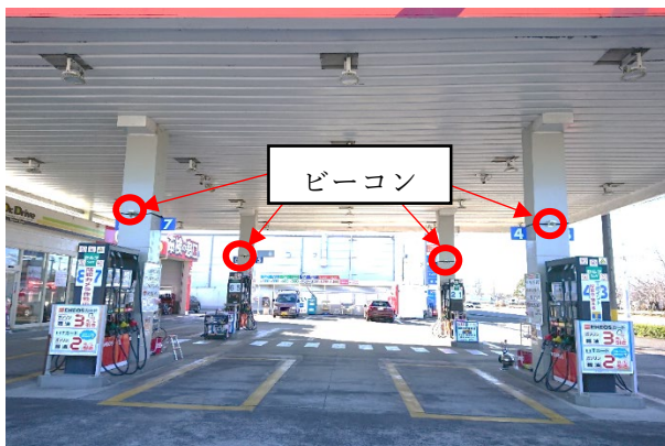
図9 ビーコン設置位置（大規模施設）
