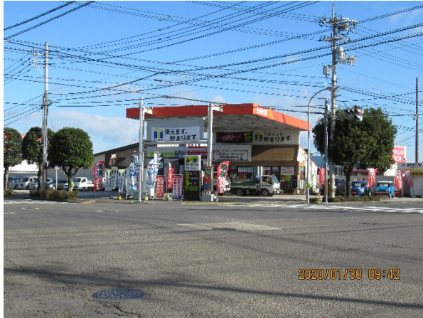
写真1 給油取扱所全景
