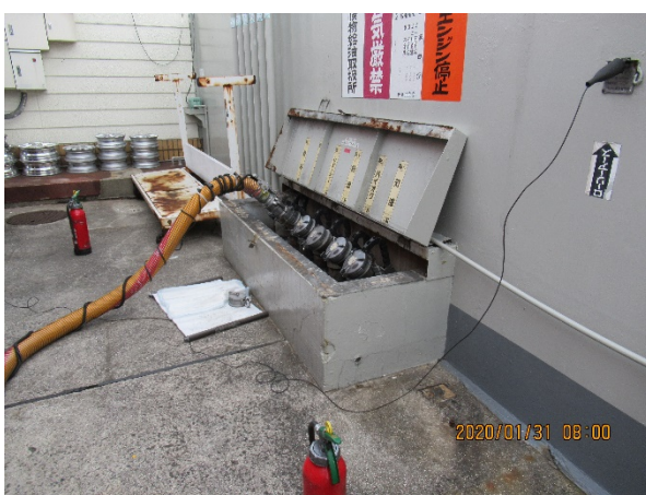
写真11 荷卸しの状況
