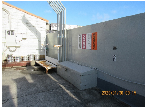
写真4 遠方注入口及び通気管の状況
