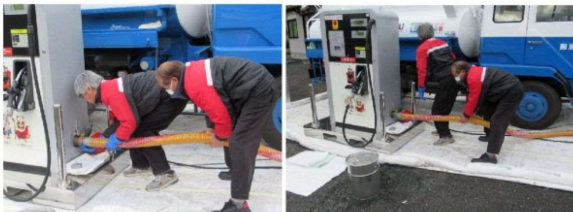
タンクローリーとスタンドの接続作業
