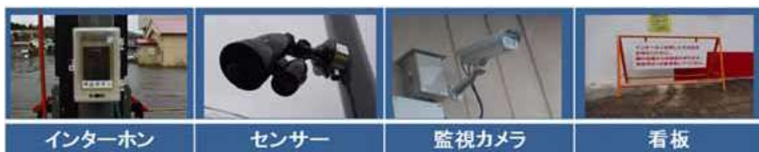
図2機器の設置状況
