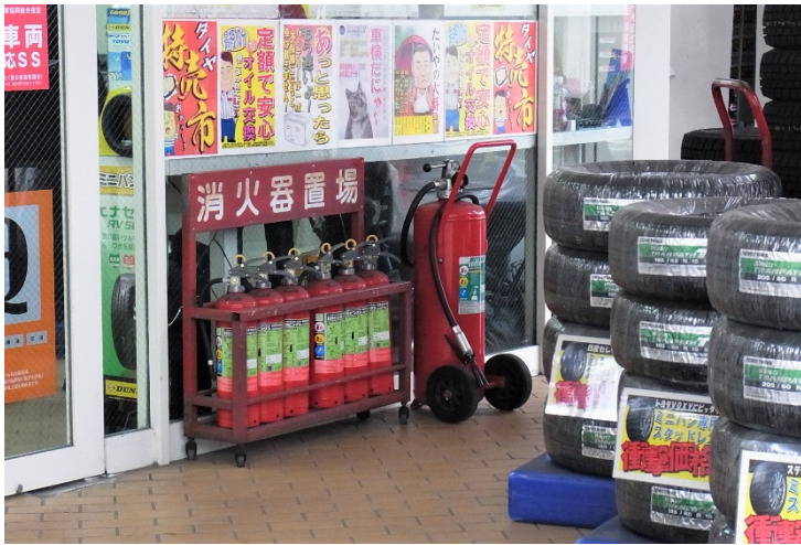
消火設備（消火器）
