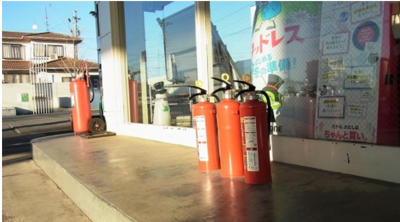
消火設備（消火器）
