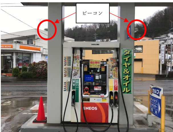
図6 ビーコン設置位置(小規模施設)
