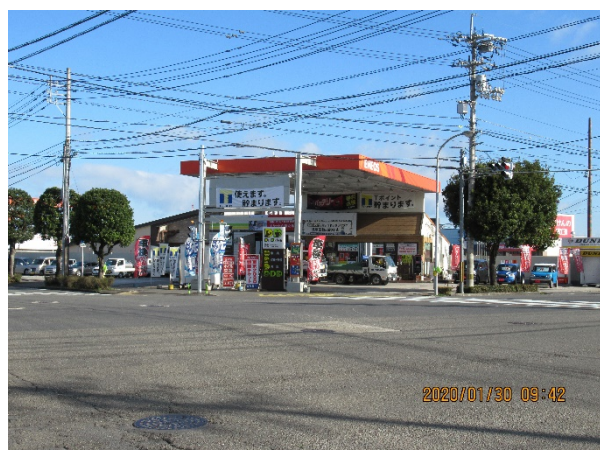
写真 1 給油取扱所全景
