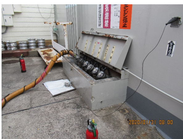
写真11 荷卸しの状況
