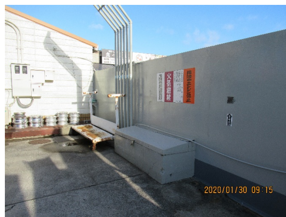
写真 4 遠方注入口及び通気管の状況
