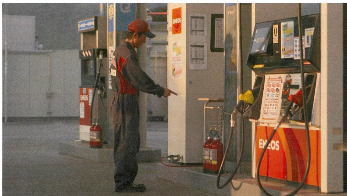
消火器の確認。決まった本数が備え付けられているか確認。
