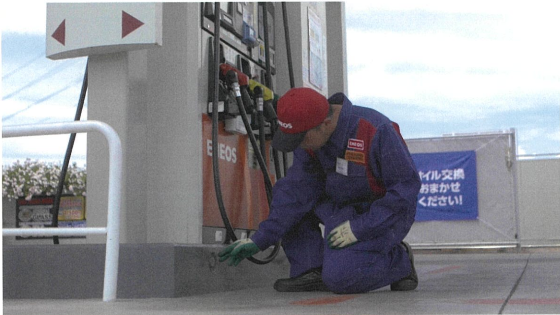
セルフスタンドの消火設備吐出口。変形、損傷はないか確認。
