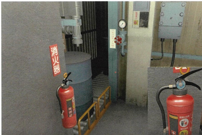
図9 消火器の確認状況
