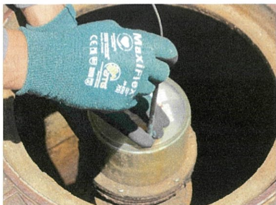
③検水口へ検水棒を挿入する
