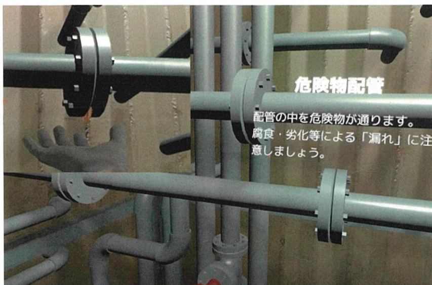
図8 危険物配管の確認状況
