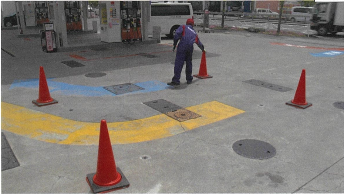
点検前にカラーコーン等で点検範囲を明示。
