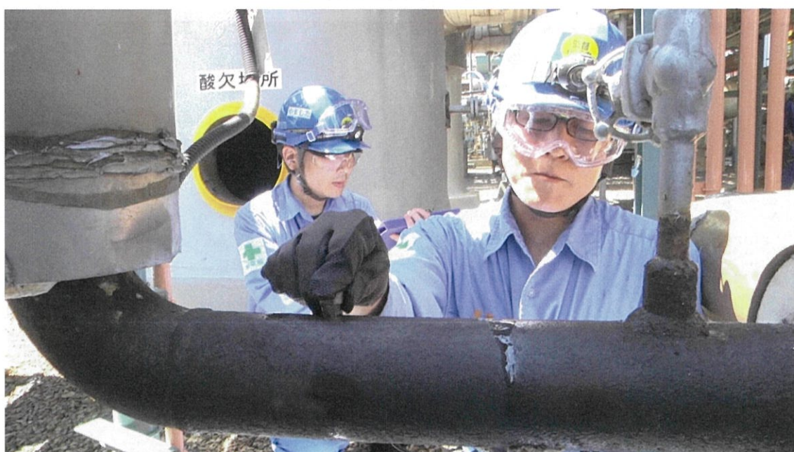
超音波厚さ計による配管の肉厚測定。配管の余寿命管理には定点肉厚測定が有効。
