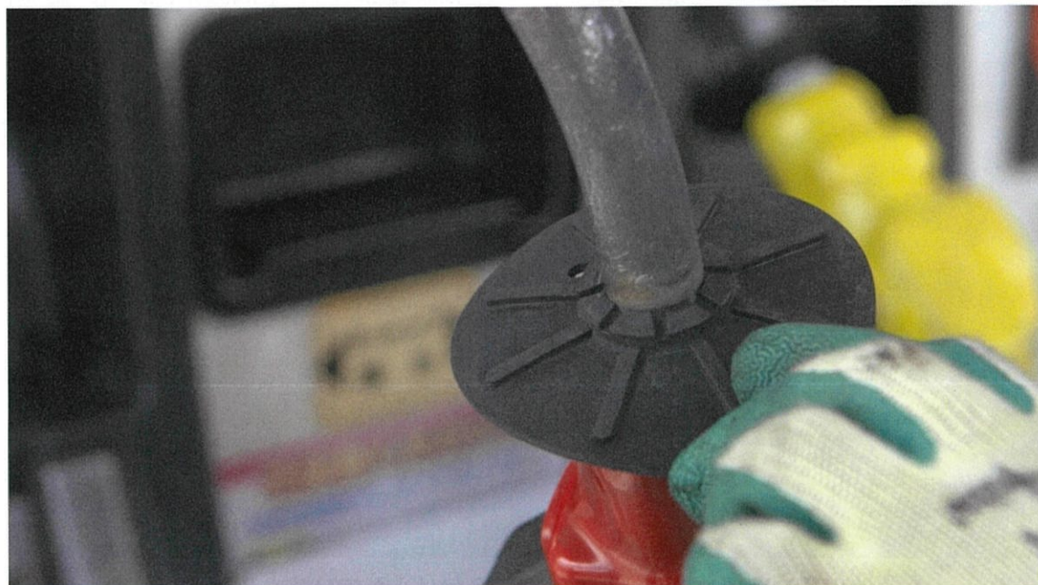
スプラッシュガードの確認。亀裂、変形はないか確認。
