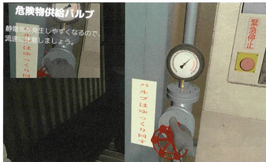
図11 バルブの操作状況
