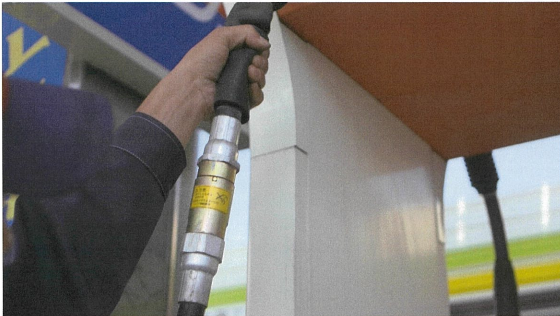
安全継手の確認。分離部に異常な隙間が開いていないか、変形、損傷がないかを確認。
