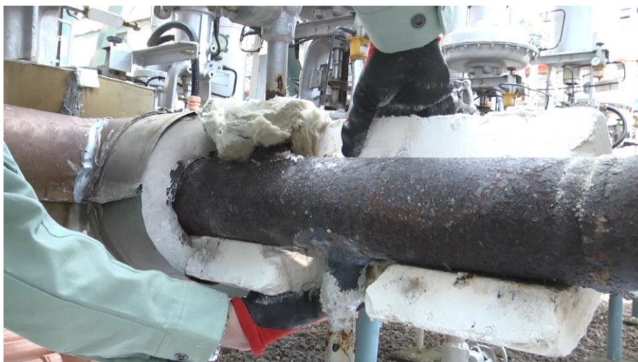
保温材をカッター等で切断し、剥がす。
