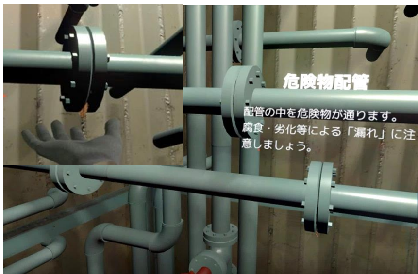
図－３１ 危険物配管の確認状況
