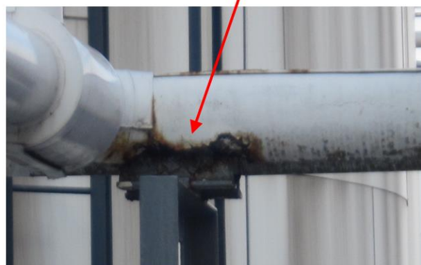
保温配管エルボ部の背側がエビ構造外装板の場合は、ずれや損傷により雨水が侵入しやすい
