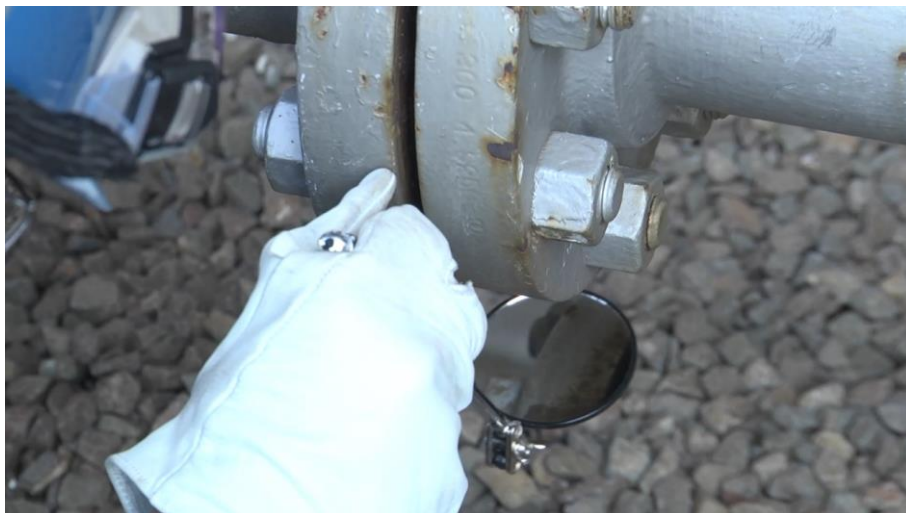
配管等の点検において、死角になる箇所は点検鏡等を用いて点検する。
