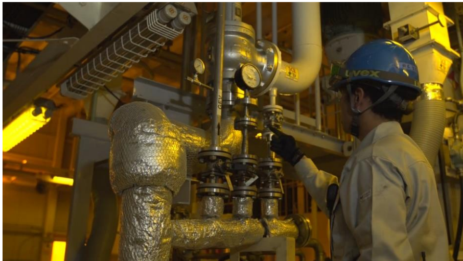
計器の指示部、取り付け状態を確認。
