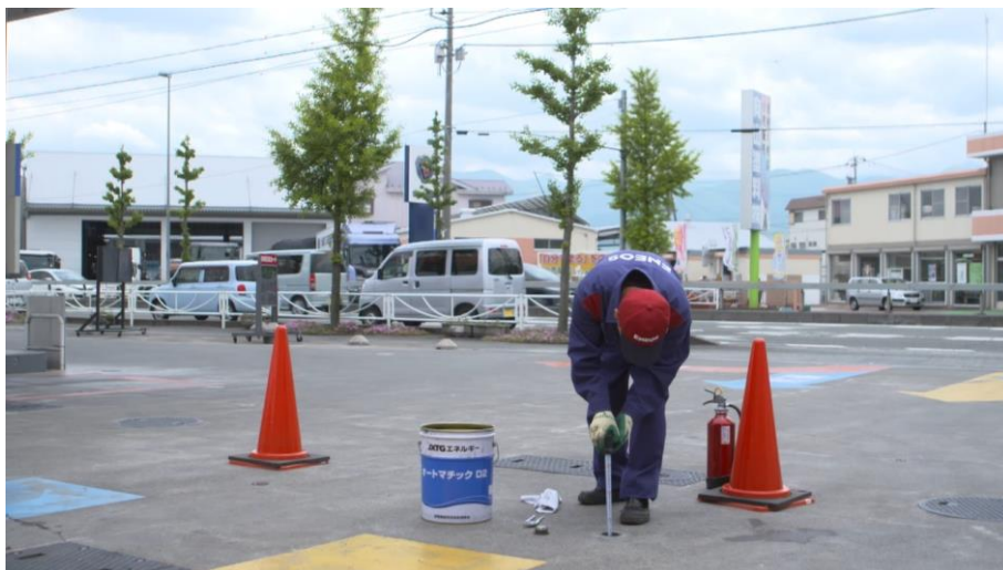
検査棒を漏洩検査管内に入れる。メジャーは深さの測定もできる。
