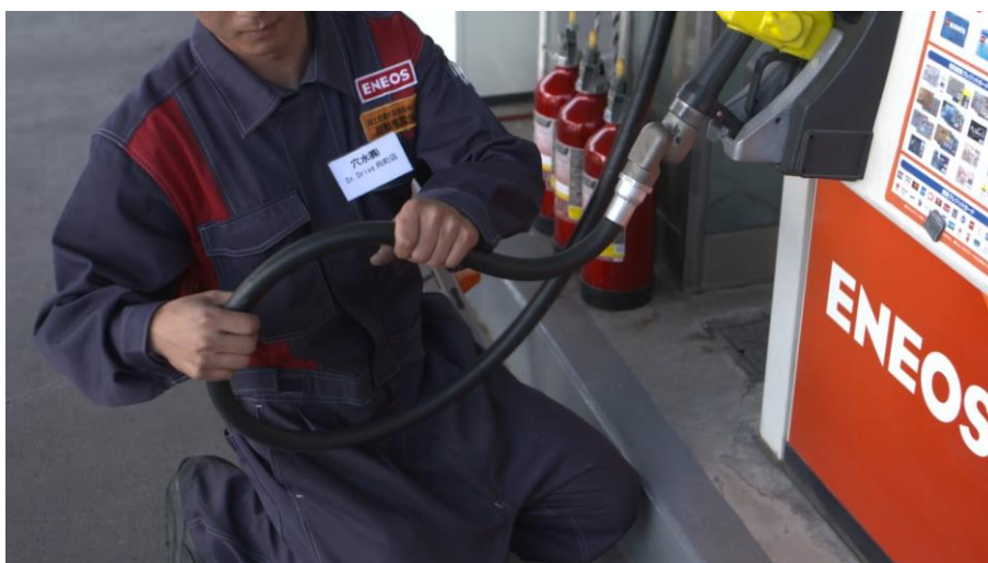
ホースの確認。軽く湾曲させ、亀裂、めくれ、変形、破損がないか確認。
