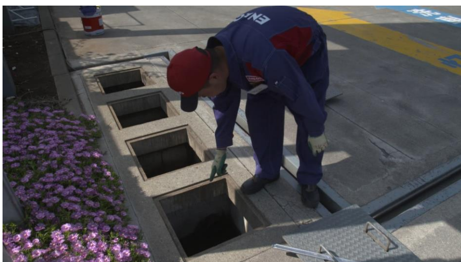
油水分離槽の確認。油は浮いていないか、損傷はないか確認。
