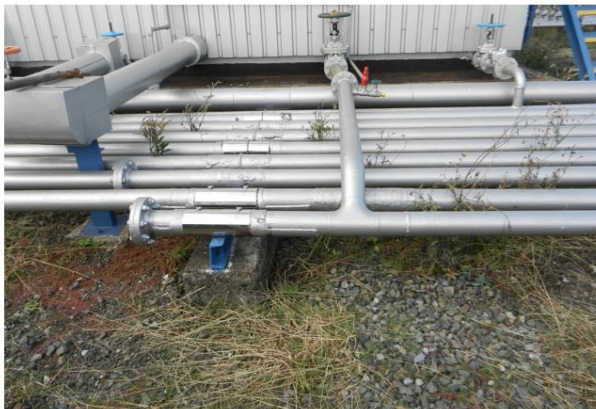
配管と地盤面と堆積土砂等が接触している箇所
