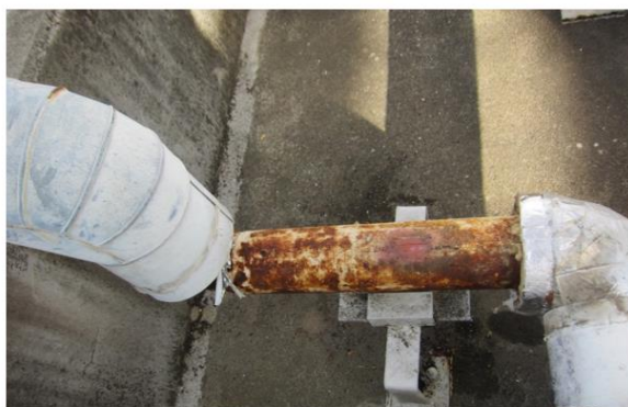
保温材を解体し復旧する場合は、 防水性能が低下しないようにする
