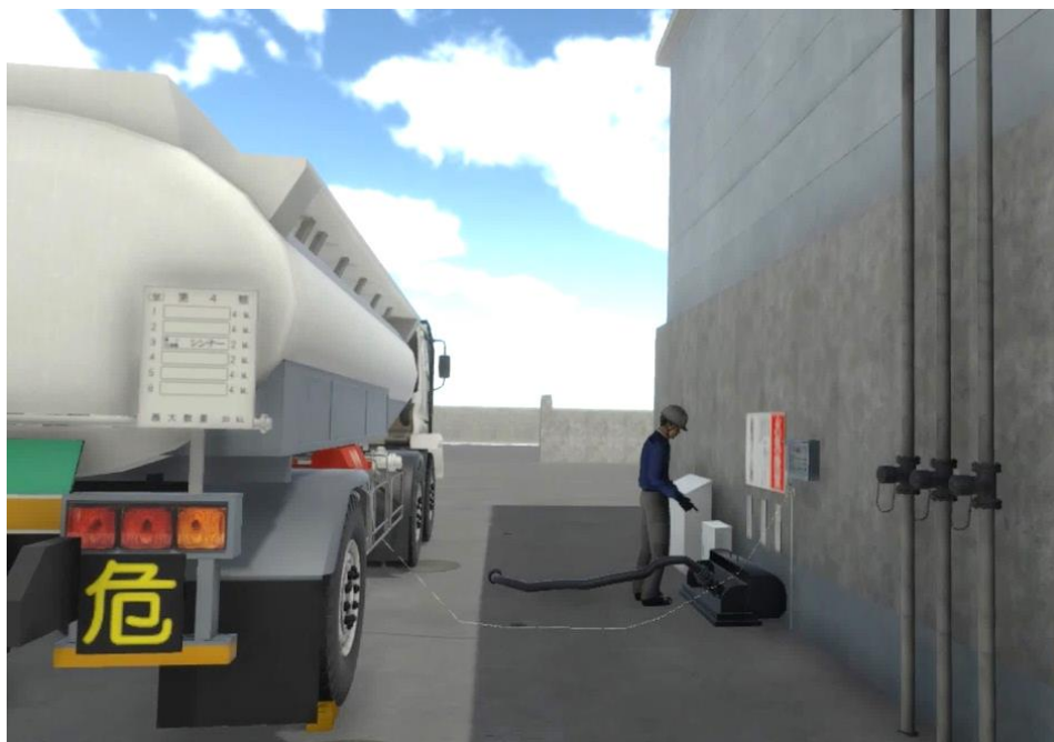
図－２１ ローリーアース及び注入ホースの設定状況
