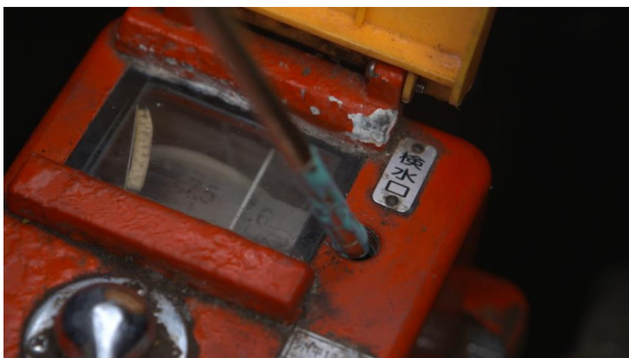
検水口から水ペーストを塗布した検査棒を入れ、タンク内の滞水を確認。
