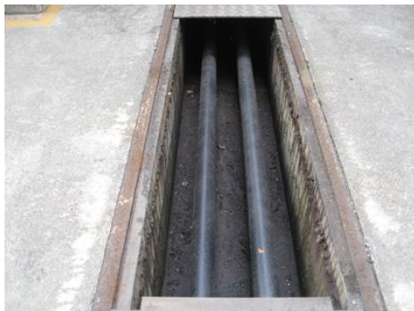
配管ピット（屋外）
