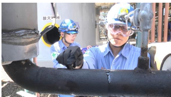
写真3 配管の肉厚測定の様子
