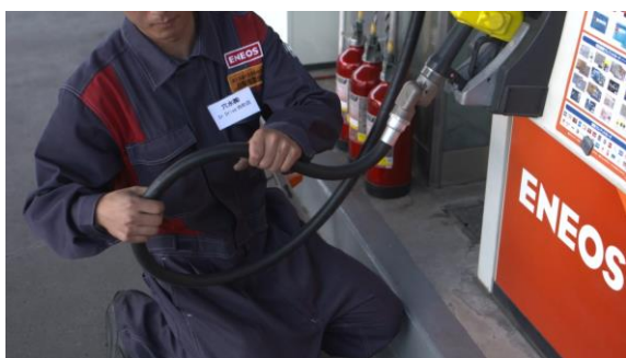
写真1 計量機ホース点検の様子
