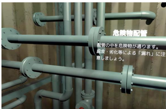
写真10 配管の点検の様子
