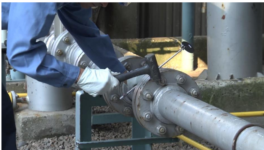
フランジの締め付け状態を確認するため、必要に応じ点検ハンマーを用いて確認する。
