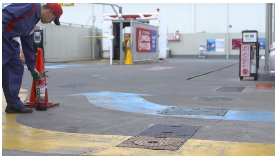
点検前に消火器を準備。
