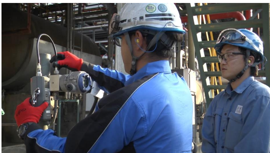
圧力校正機器を取り付け、圧力計の表示と違いがないか確認。
