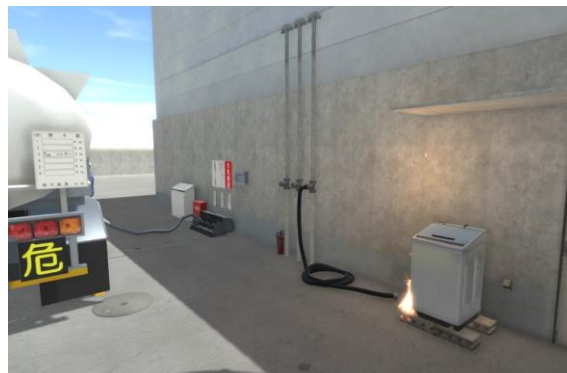
写真9 可燃性蒸気回収ホースが正しく接続されていない様子
