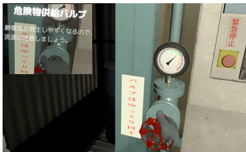
図－3 4 バルブの操作状況
