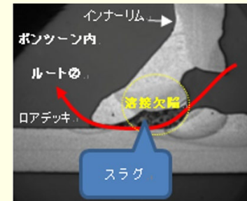
(2-4) 溶接欠陥に起因する割れ
