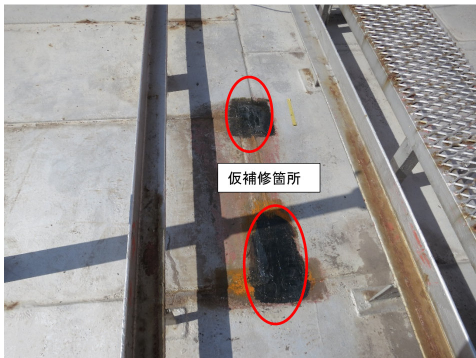
図 3 - 2 浮き屋根の仮補修（アクアパテ+ウルトラシール+エラストマー）
