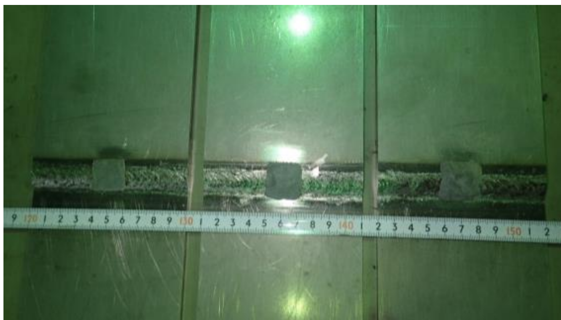
図 5-4-1 応急処置状況写真(措置④、レクターシール、施工範囲 A)
