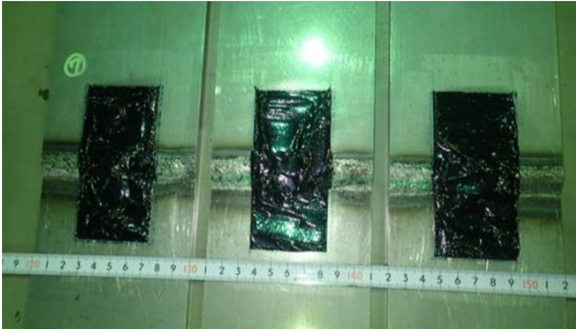
図 5-7 応急処置状況写真(措置⑦、マルチメタル+エラストマー、施工範囲 B)
