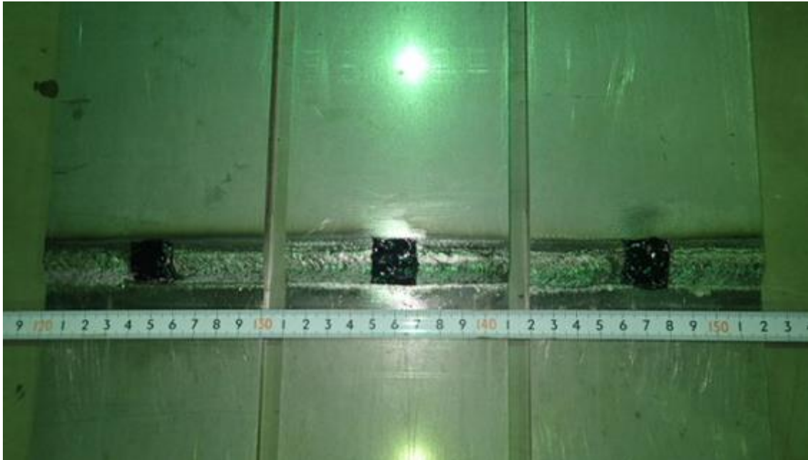
図 5-6-1 応急処置状況写真(措置⑥、エラストマー、施工範囲 A)
