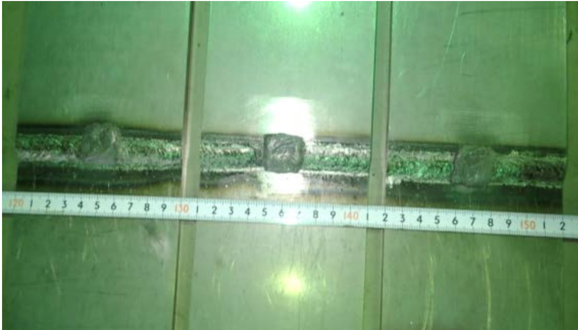
図 5-5-1 応急処置状況写真(措置⑤、マルチメタル、施工範囲 A)
