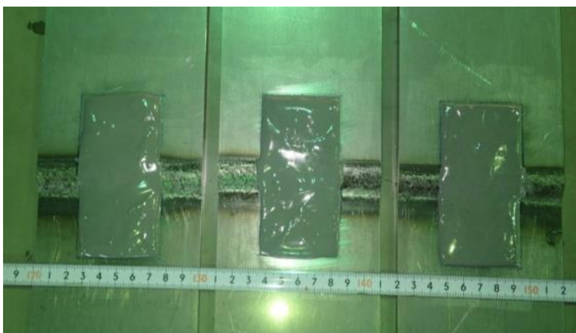
図 5-2-2 応急処置状況写真(措置②、バロメタル、施工範囲 B)
