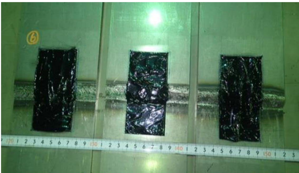
図 5-6-2 応急処置状況写真(措置⑥、エラストマー、施工範囲 B)
