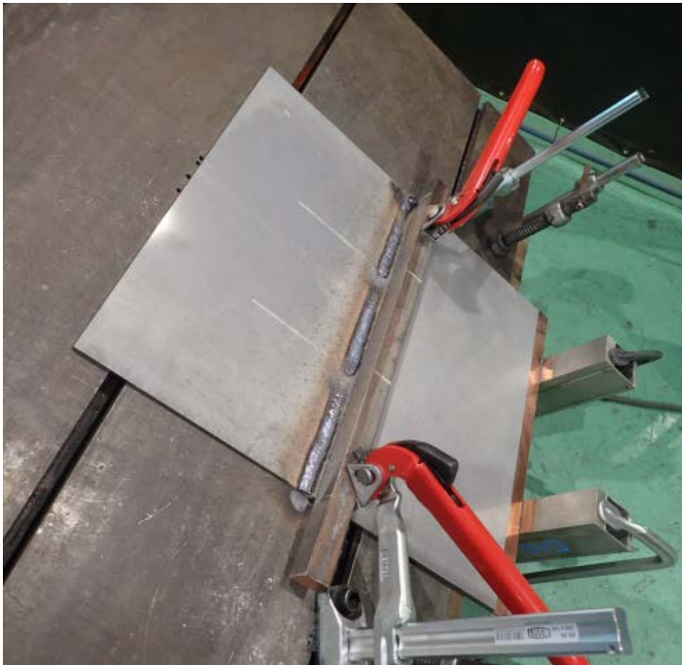
図 2-5 溶接後の重ね隅肉溶接ビード外観
