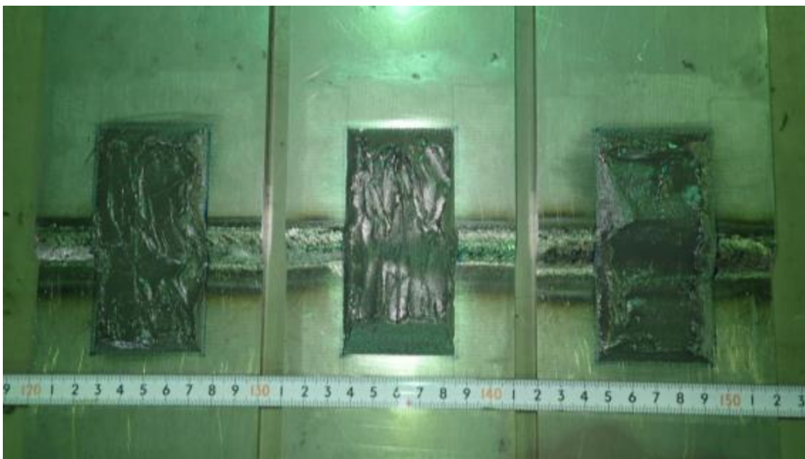
図 5-3-2 応急処置状況写真(措置③、デブコン、施工範囲 B)
