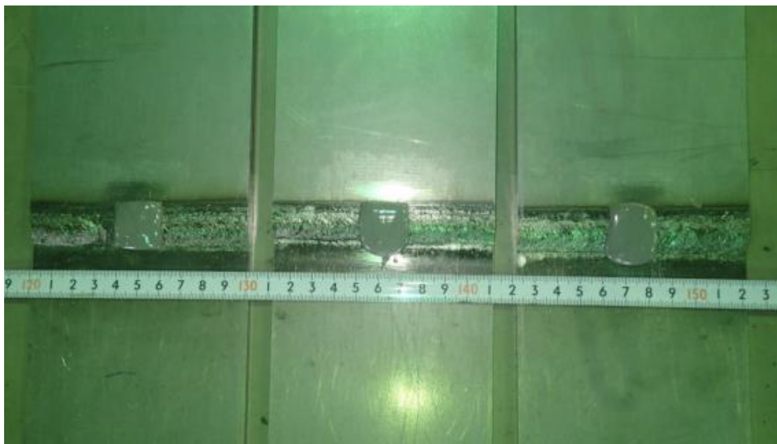
図 5-2-1 応急処置状況写真(措置②、バロメタル、施工範囲 A)
