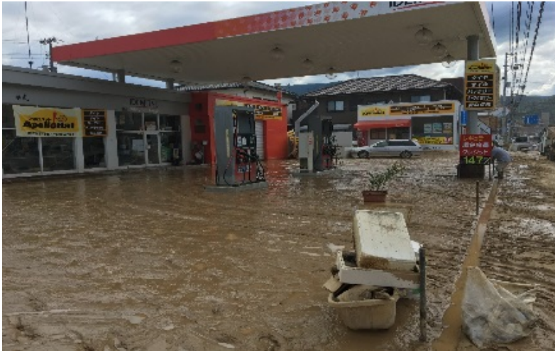
給油取扱所への土砂流入した事例
