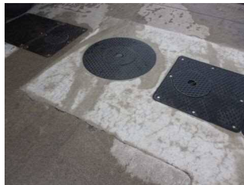
地下貯蔵タンクへのマンホール新設
