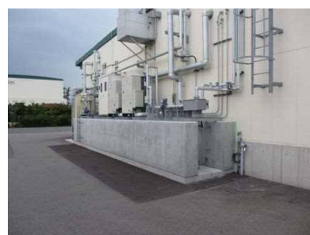
空調設備等のかさ上げ
