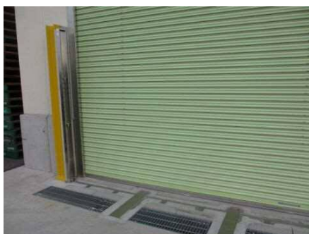
止水板の設置場所
