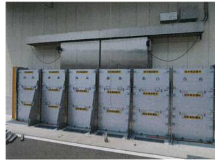
止水板の設置状況（自社倉庫）
