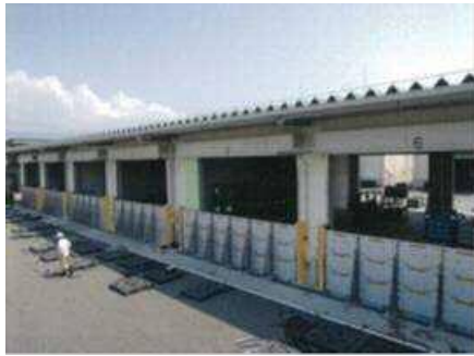
止水板の設置状況（自社倉庫）
