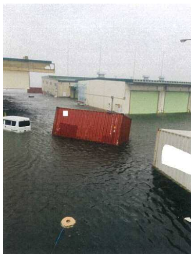
屋内貯蔵所周りの浸水状況
