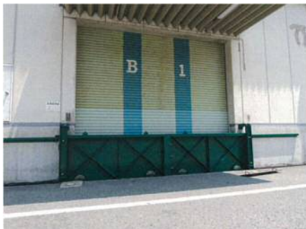
止水板の設置状況（神戸市倉庫）
