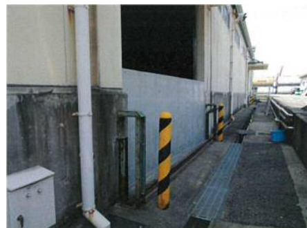
倉庫出入口にコンクリート壁設置
