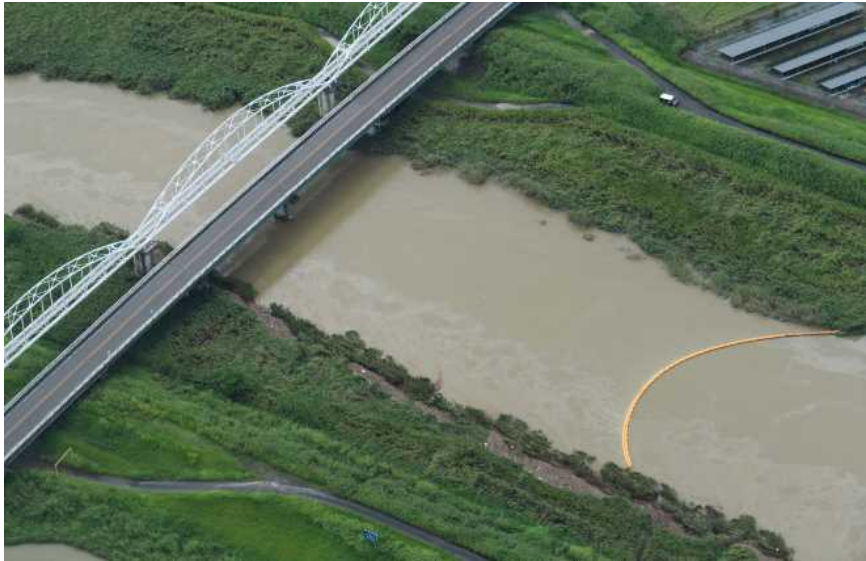
河川へのオイルフェンスの設置
