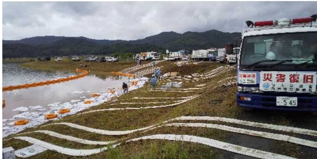
排水ポンプ車による排水作業
