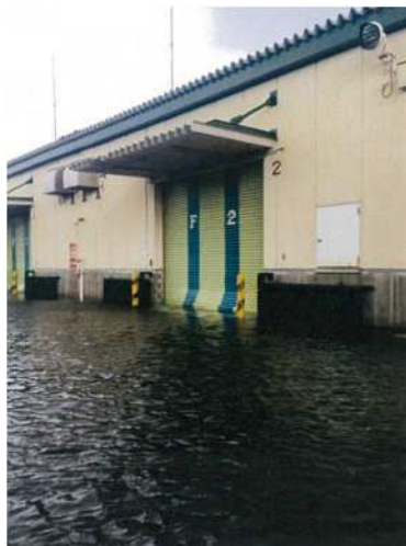
シャッターの破損
