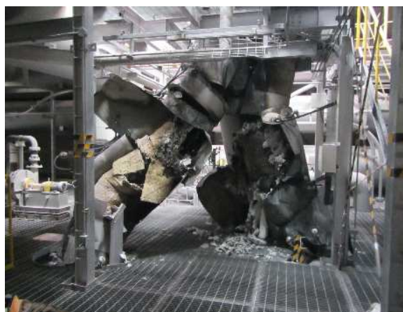
熱分解ガスダクトの被災状況
