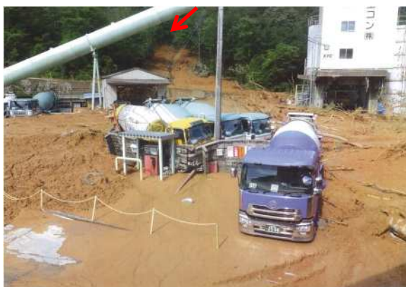
土砂崩れ発生箇所～危険物施設周辺
