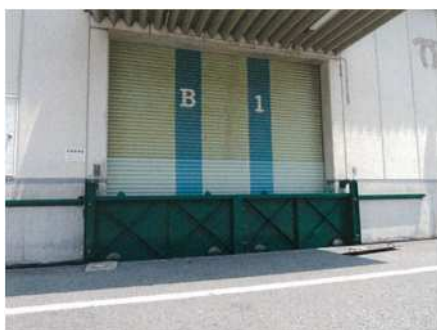
止水板の設置状況（神戸市倉庫）
