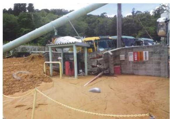
自家用給油取扱所周辺の状況
