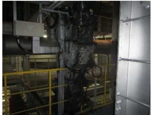
熱分解ガスダクトの被災状況
