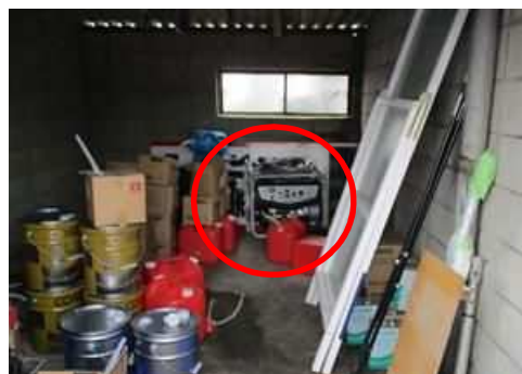
自家発電設備を更新
