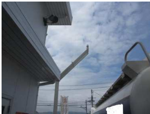
通気管への対策（0.5mかさ上げ）
