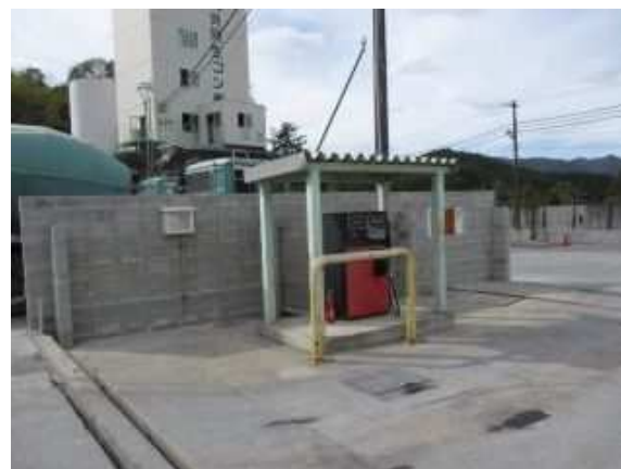
自家用給油取扱所の復旧状況
