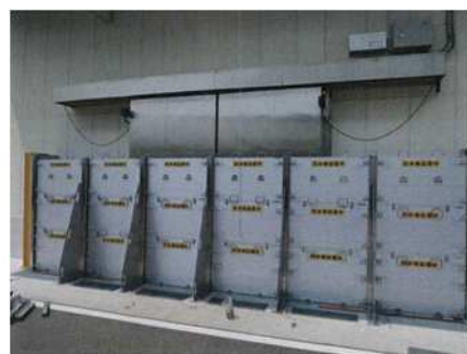
止水板の設置状況（自社倉庫）
