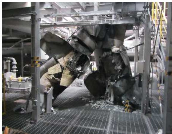
熱分解ガスダクトの被災状況
