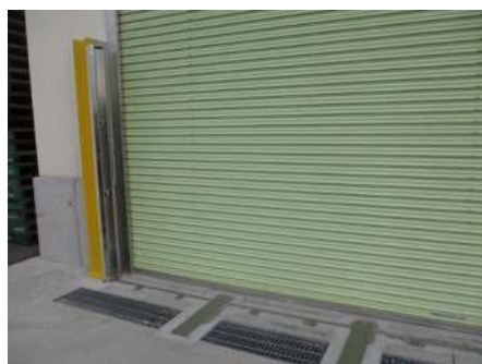
止水板の設置場所
