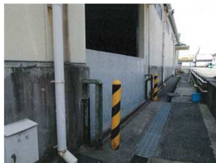
倉庫出入口にコンクリート壁設置
