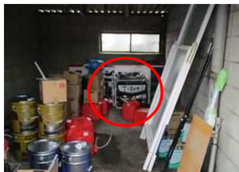
自家発電設備を更新
