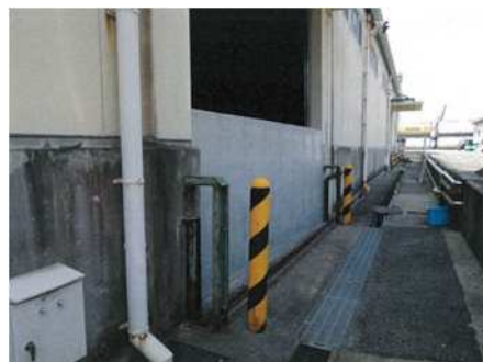
倉庫出入口にコンクリート壁設置
