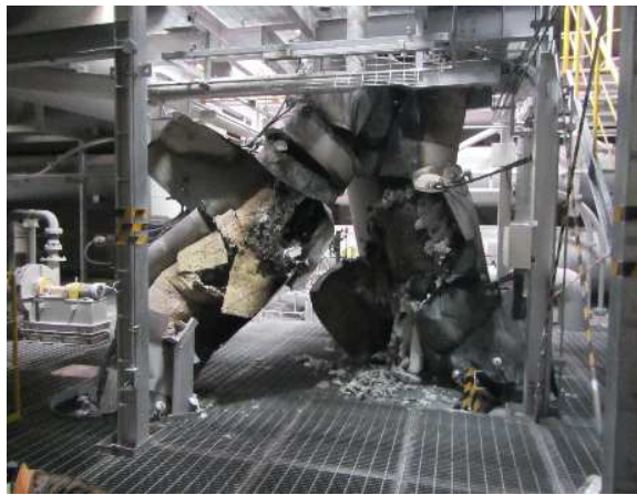
熱分解ガスダクトの被災状況
