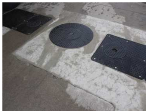
地下貯蔵タンクへのマンホール新設
