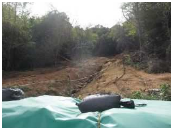
土砂崩れ発生箇所の状況
