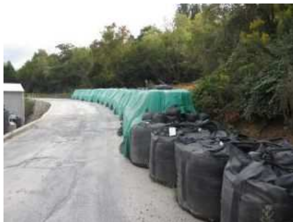
敷地境界に土嚢を設置
