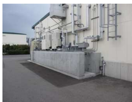
空調設備等のかさ上げ
