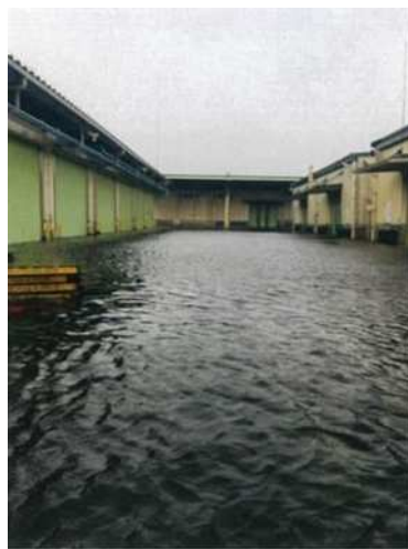
屋内貯蔵所周りの浸水状況
