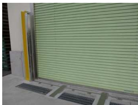
止水板の設置場所
