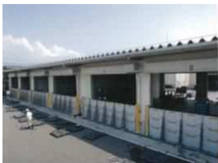
止水板の設置状況（自社倉庫）
