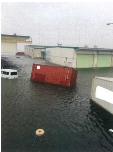
屋内貯蔵所周りの浸水状況
