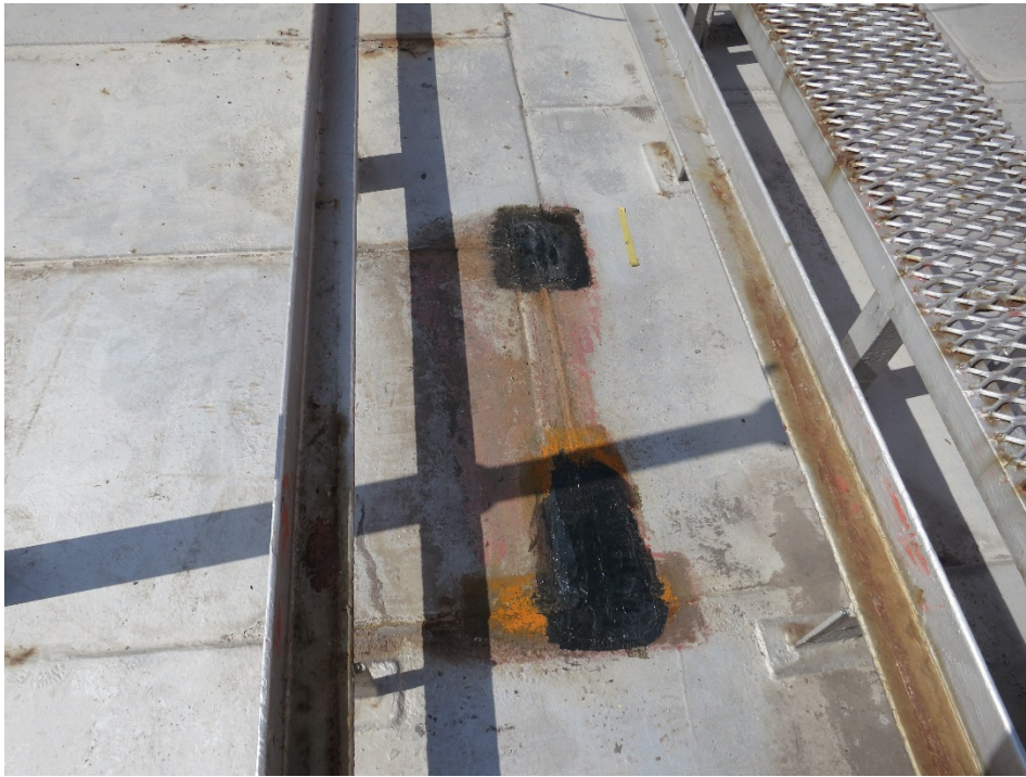
図 17 浮き屋根の応急措置（アクアパテ+ウルトラシール+エラストマー）
