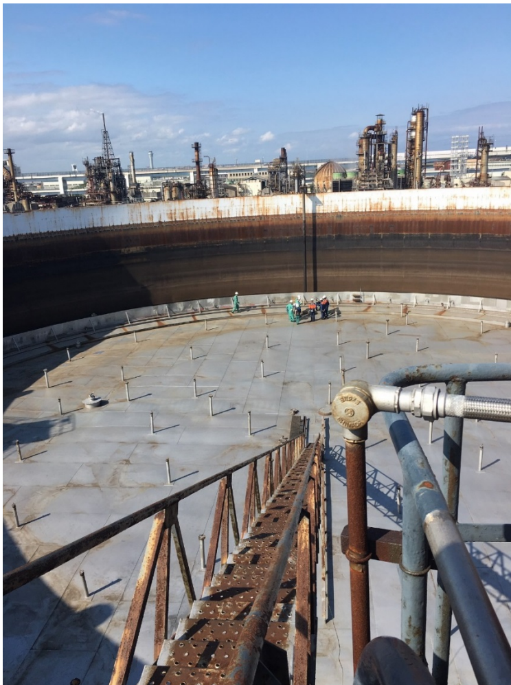
図 16 浮き屋根の現地調査風景
