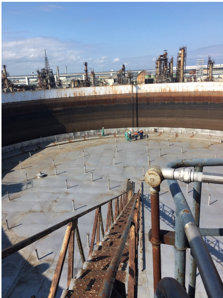
図 13 浮き屋根の現地調査風景
