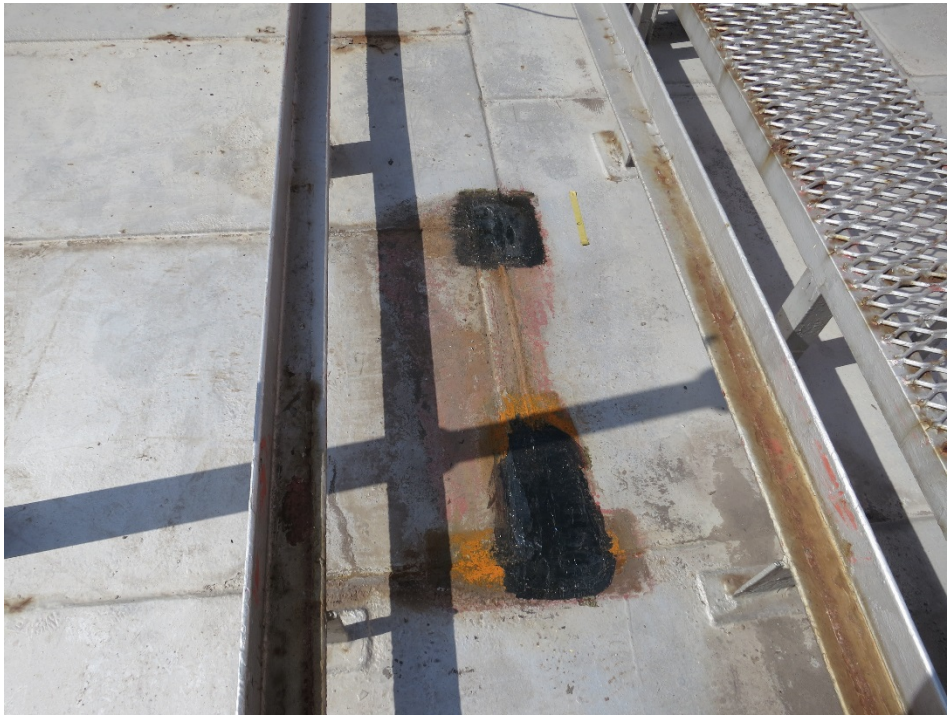
図 14 浮き屋根の応急措置（アクアパテ+ウルトラシール+エラストマー）
