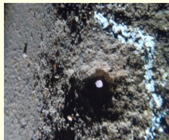
(1-1)内面腐食穿孔
