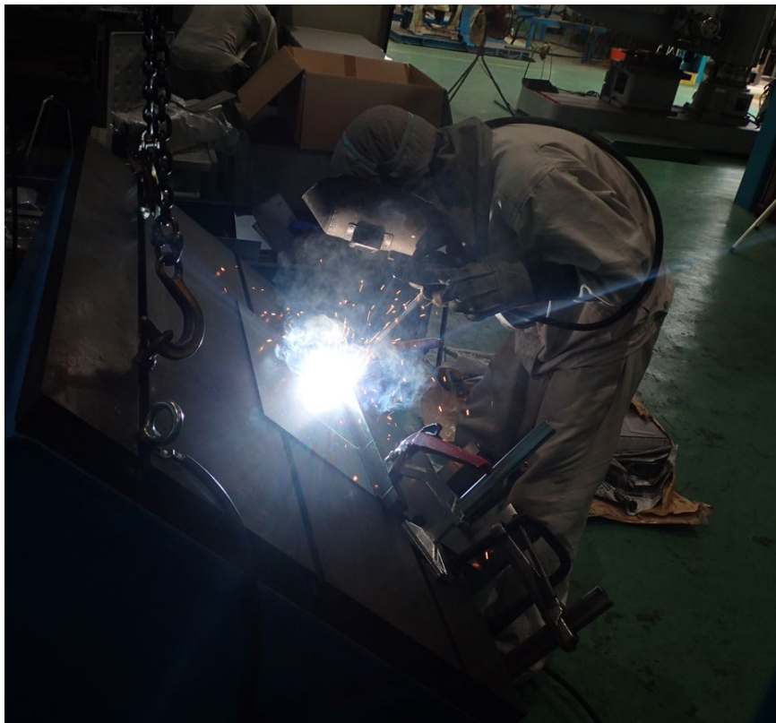
図 2-4 被覆アーク溶接作業
