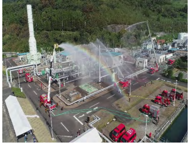
【火災性状監視】
