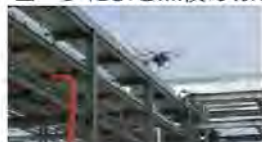
ドローンによる点検の様子
