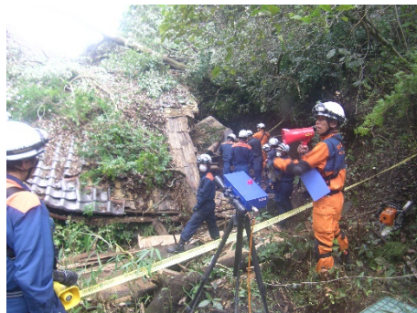
【崩落監視システム】
