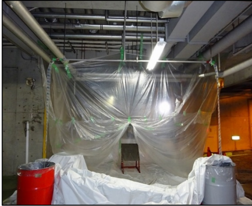
養生を施した例
