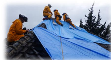
ブルーシートによる家屋の応急補修活動 (提供:習志野市消防本部)
